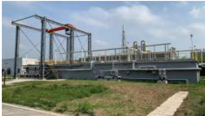
新建污水收集及處理系統
